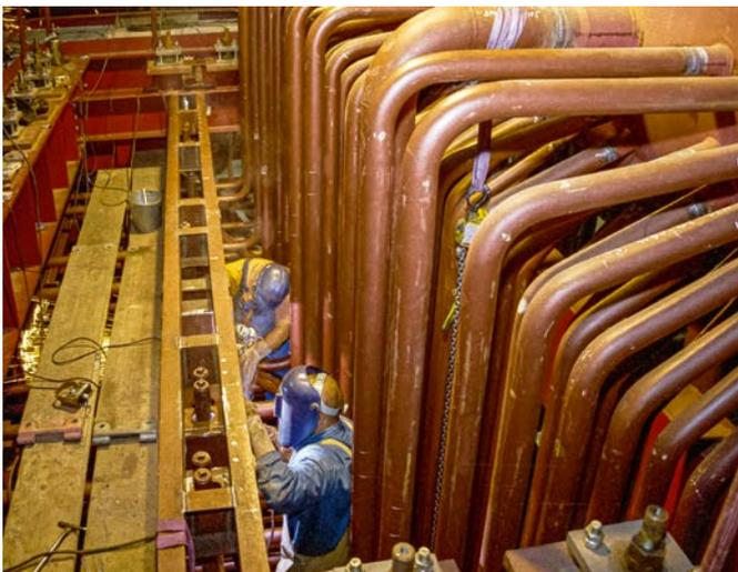
Schweißarbeiten an der Kesseltrommel
