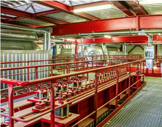
Kesseldecke mit Dampftrommel
